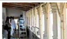
Detalle de la tercera planta.
