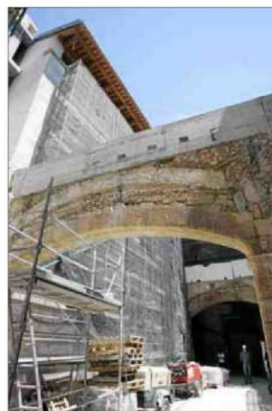
Arcos reforzados de Can Oleo.
