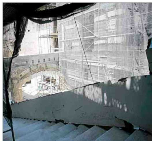
Fachada interior del edificio con andamiajes.
