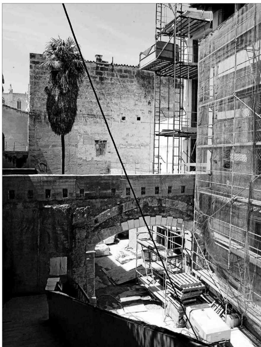
Obras de rehabilitación de Can Oleo, ayer, edificio de la UIB en el casco antiguo. ■ Fotos: PERE BOTA
