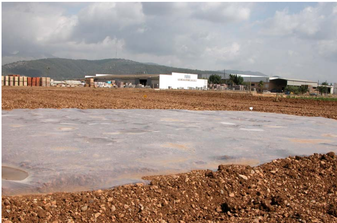
Figura 9. El sistema de solarització es basa en la col·locació de làmines de plàstic transparent sobre la terra per tal d'aconseguir un efecte hivernacle a la interfície terra-aire
